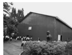
雨天体育施設
